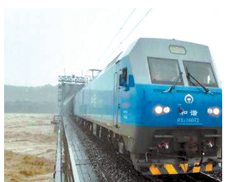
货物列车对涪江铁路大桥进行压梁。
