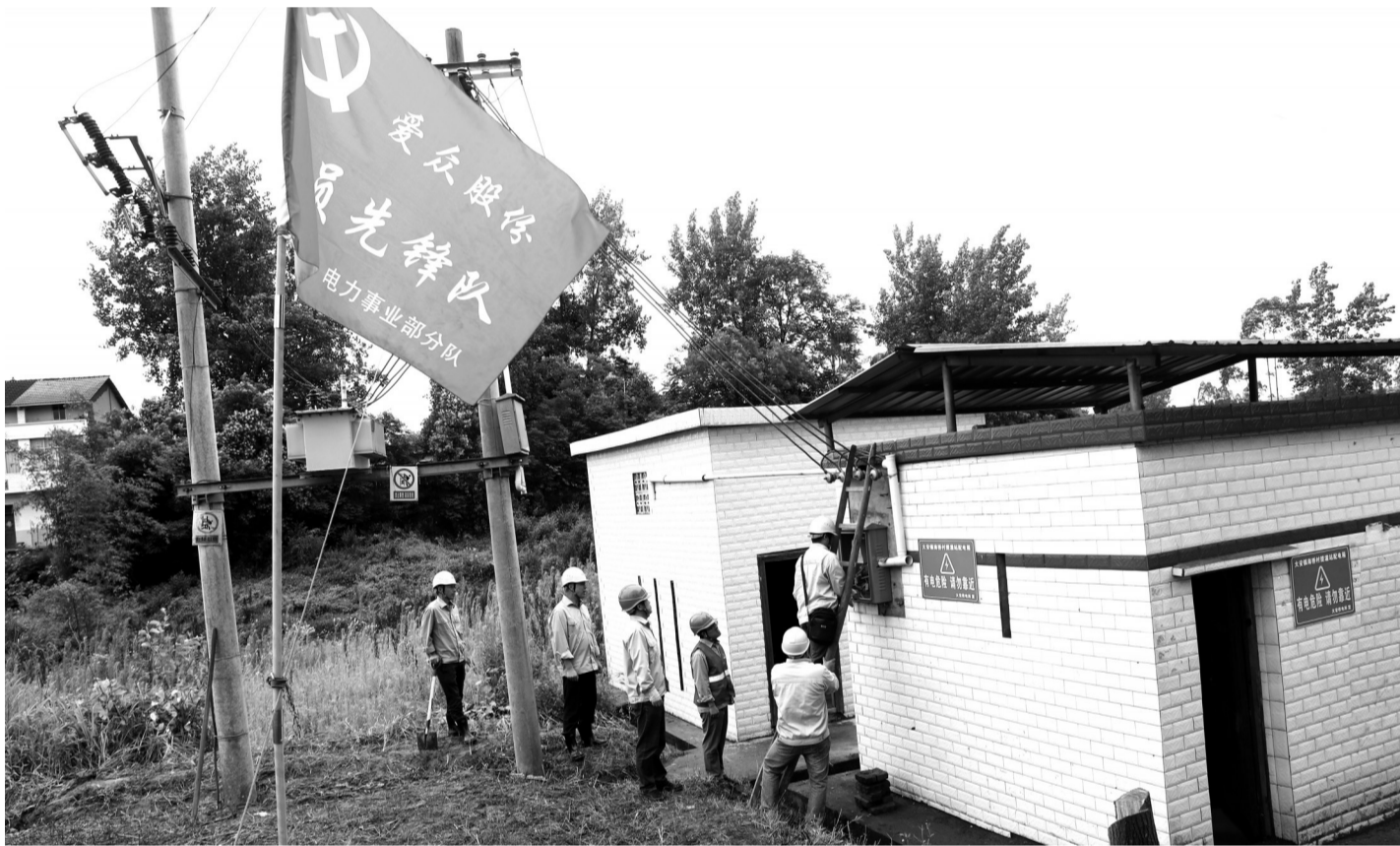
党史学习教育开展以来,四川广安爱众股份有限公司电力事业部积极组织党员干部职工、电力工人志愿者深入辖区开展志愿服务活动。图为6月3日,公司电力事业部供电支部党员先锋队的志愿者在对广安区大安镇南桥村提灌站的线路进行检查和维护。
