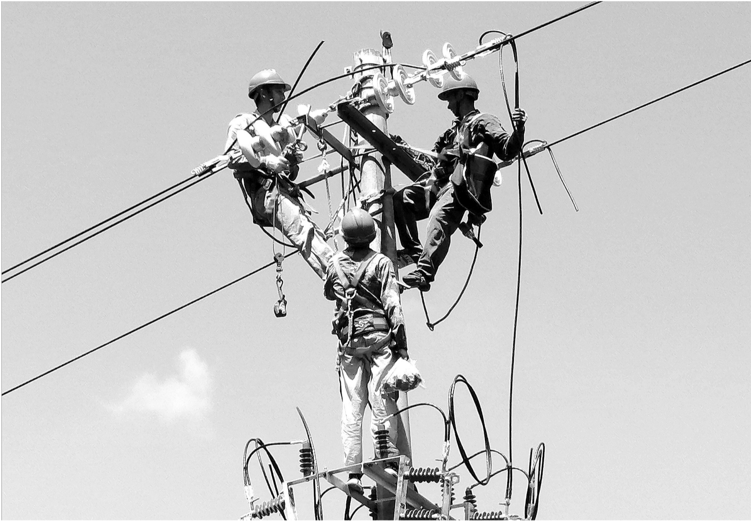
入伏以来，湖北省竹山县开启“烧烤”模式，用电负荷不断攀升，竹山县供电公司开展夏季“战高温，保供电”安全生产大排查，加班加点对部分薄弱线路、设备进行增容变压器、电网改造等措施，彻底解决重载、过负荷状况，确保全县夏季用电安全稳定可靠。图为7月26日，在竹山县城关镇刘家山村，竹山县供电公司施工人员冒着高温进行农网升级改造施工。
