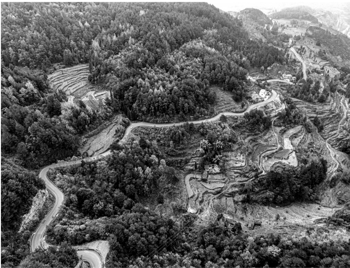
近年来,贵州省黔西市中坪镇加大乡村公路建设力度,在峡谷、悬崖、绝壁上修建了乡村公路,全力推进“四好农村路”建设,助推百姓致富。图为11月29日,航拍的黔西市中坪镇洗坪村蜿蜒的通村公路。周训超摄
