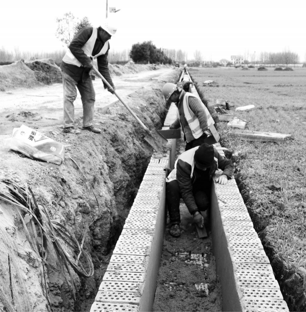
入冬以来,河南省平顶山市湛河区结合高标准农田总体规划,抢抓冬修水利黄金期,全力推进水利基础设施建设,为促进农业农村高质量发展提供坚强的水利保障。图为12月10日,施工人员在河南省平顶山市湛河区曹镇乡曹东村田间修建水渠。
