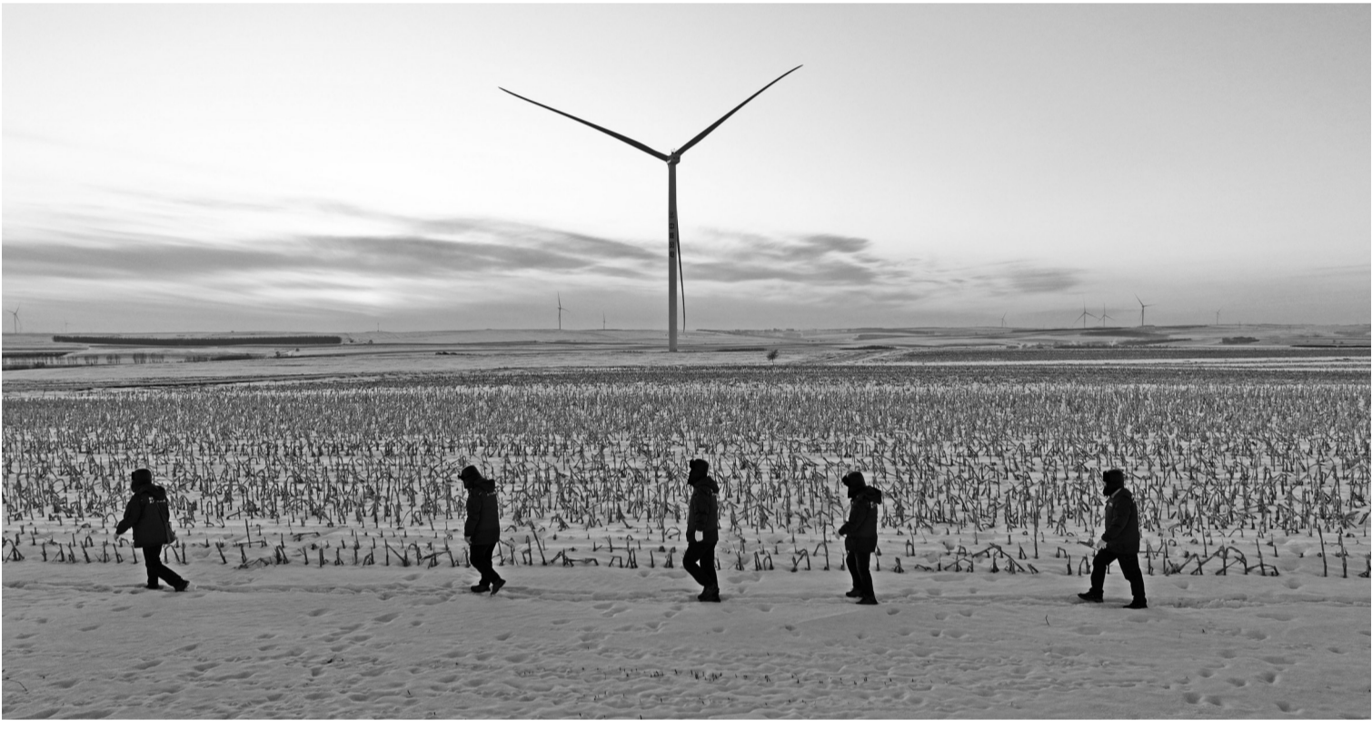
近日，内蒙古自治区呼伦贝尔市迎来寒潮天气，局部地区达到零下30多摄氏度，呼伦贝尔国网扎兰屯市供电公司和呼伦贝尔新正电工公司密切关注气温和用电负荷变化，组织工作人员做好设备隐患排查，对线路进行不间断安全巡视，及时消除异常情况，确保恶劣天气下民生供电安全。图为12月14日工人们冒着严寒巡查电力线路。
