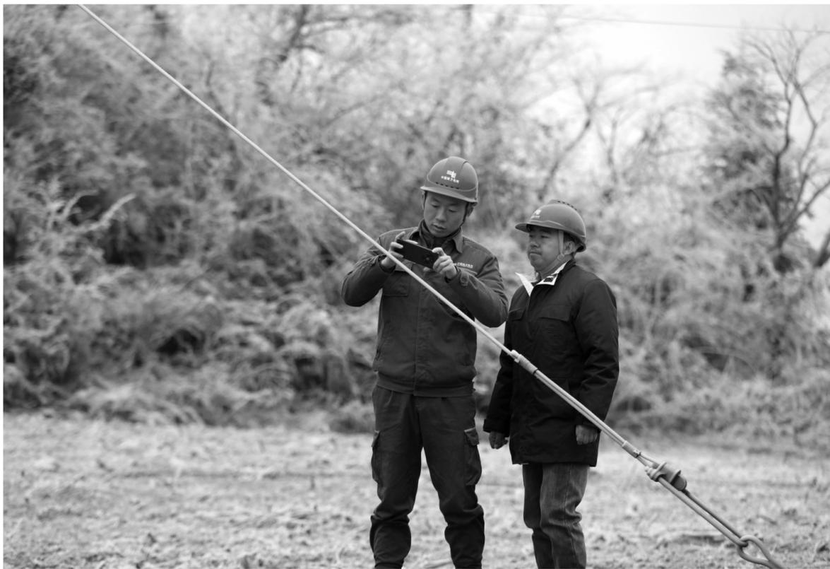
近日，受强冷空气影响，贵州省多地连续出现低温凝冻天气，贵州省黔东南苗族侗族自治州施秉县供电局及时组织工作人员对10千伏配电线路开展观冰特巡工作，检查设备运行情况，确保恶劣天气环境下的供电线路安全稳定运行。图为12月18日，工作人员进行覆冰厚度测量。
