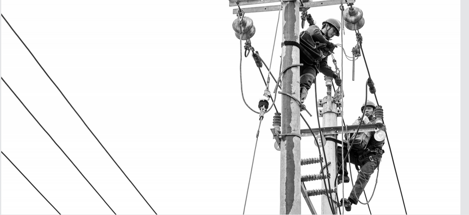
受近期持续寒潮天气影响，贵州省铜仁市玉屏侗族自治县部分电力设施损坏，当地供电局组织工作人员加班加点展开抢修工作，全力保障企业及居民用电安全。图为1月25日，工作人员对损坏的电力设施进行抢修。
