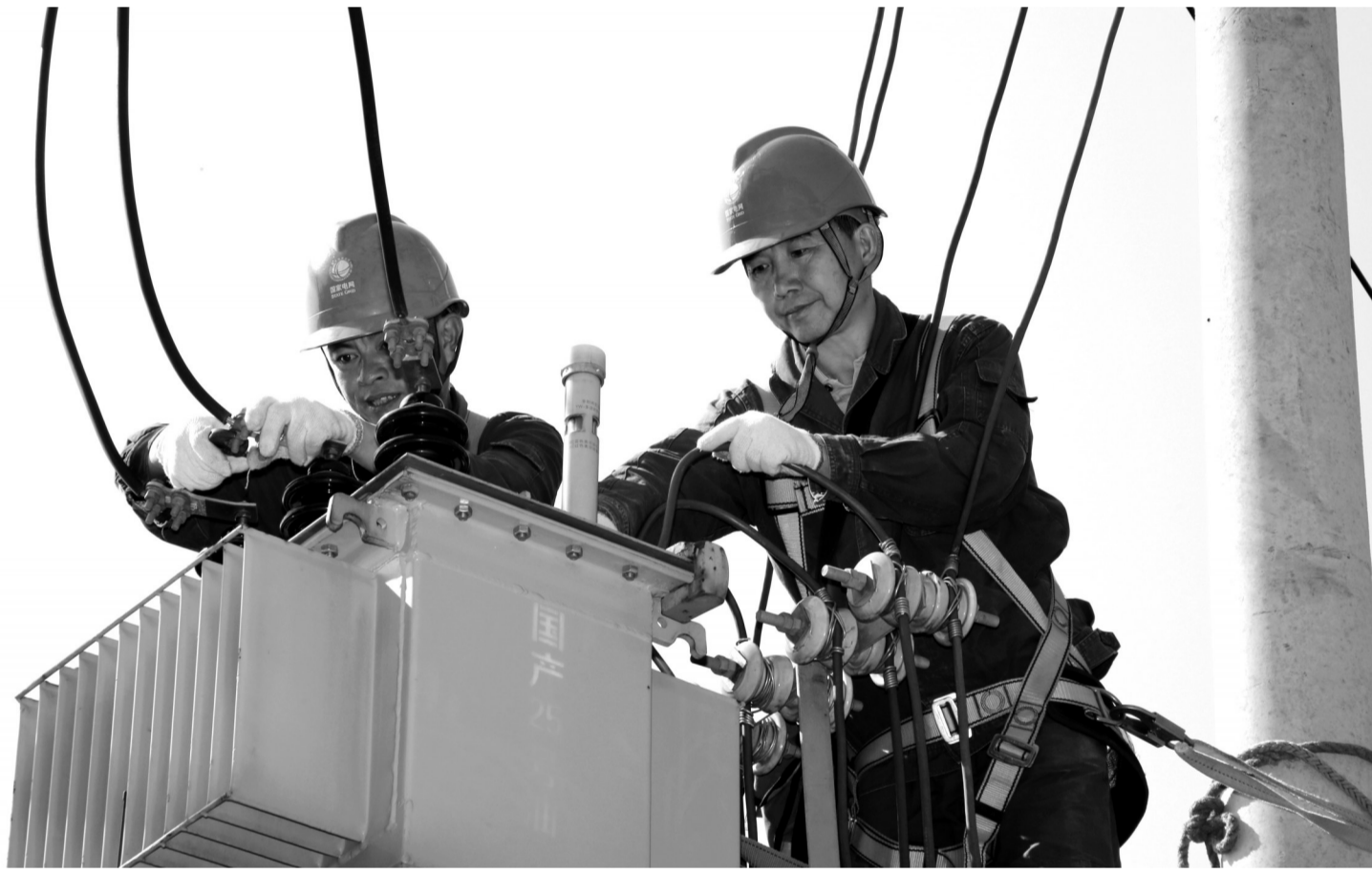
连日来，四川省泸州市纳溪区持续出现高温天气，用电负荷不断攀升，国网泸州市纳溪供电公司广大职工顶烈日、战高温，积极投身生产服务一线，用辛勤的汗水全力守护电力安全可靠供应。图为近日，国网泸州市纳溪供电公司员工排除电力故障。 王超明 刘益川 摄
