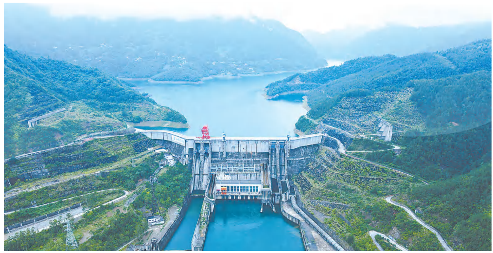
白龙江上的明珠——华电四川宝珠寺水力发电厂。
