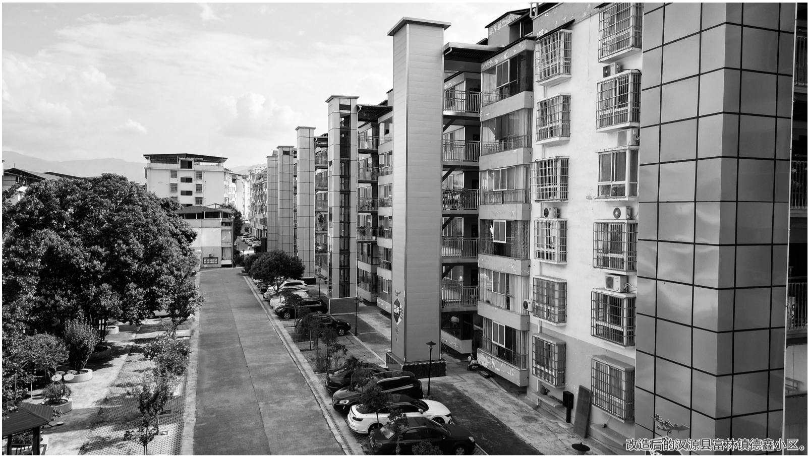
改造后的汉源县富林镇德鑫小区。
